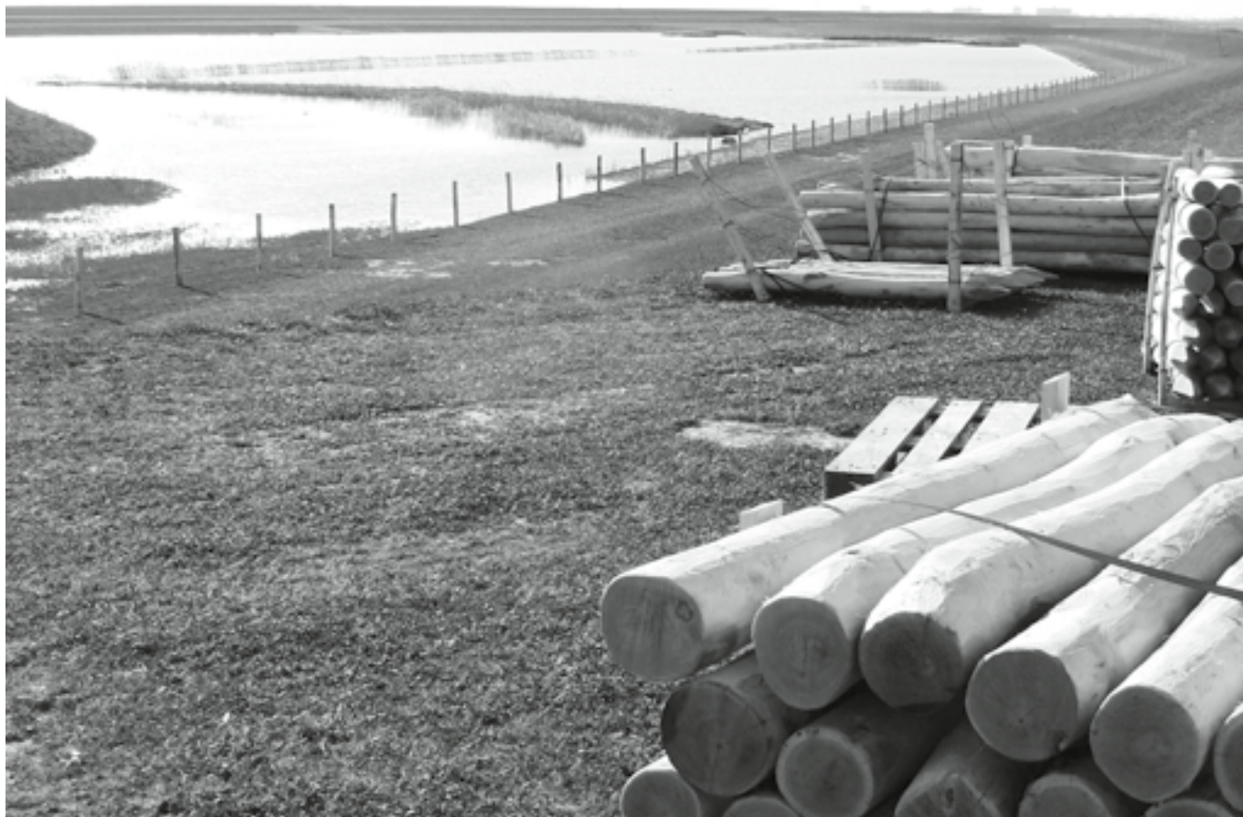
Werkzaamheden aan het hekwerk bij de dubbele dijk bij Hoog Watum. Er is daar een mooi watergebied ontstaan.
